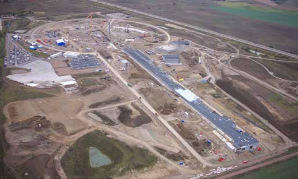
Figur 1: Flygbild över forskningsanläggningarna med ESS byggplats i förgrunden och MAX IV i bakgrunden. Mitt emellan anläggningarna området där Science Village Scandinavia ska byggas. Foto: Perry Nordeng.
